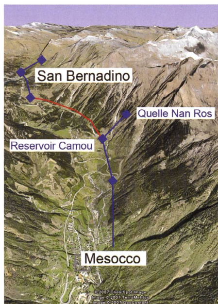
Bild 1. Mit der neuen Feuerlöschleitung (rot) entlang der Nationalstrasse N13 hätte eine umfassende Trinkwasserschleife im Misox realisiert werden können. Das Konzept hat vier entsprechend positionierte Turbinenstationen vorgesehen. Nun wird zunächst die neue Quelle Nan Ros erschlossen, in Camou Strom produziert und die Wasserversorgung für Mesocco verbessert.
