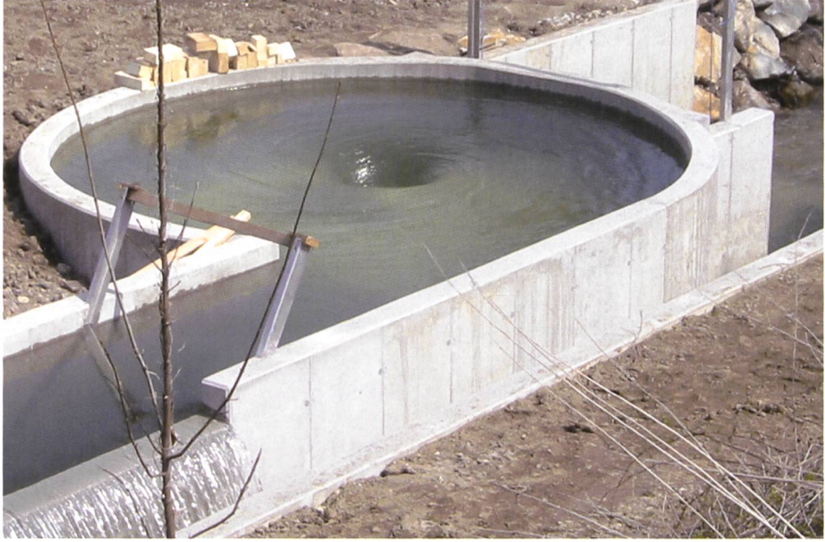
Bild 1. Gravitationswasserwirbel mit 5,5 m Durchmesser.
