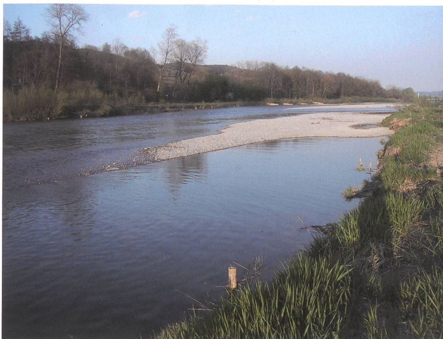
Bild 8. Gerinneaufweitung der Thur bei Niederneunform.
