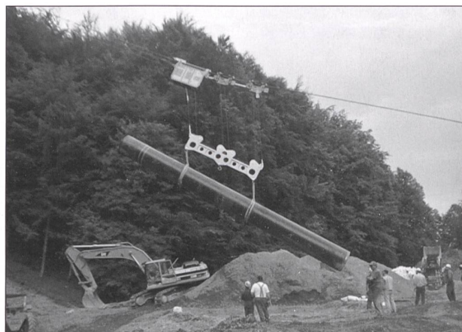
Transport und Versetzen Erdgasleitung, Rohrgewicht 12 Tonnen
