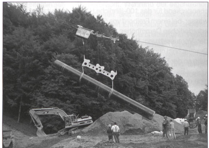
Transport und Versetzen Erdgasleitung, Rohrgewicht 12 Tonnen
