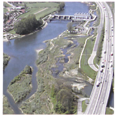
Figure 2. Rivière à poissons à Ruppoldingen.
