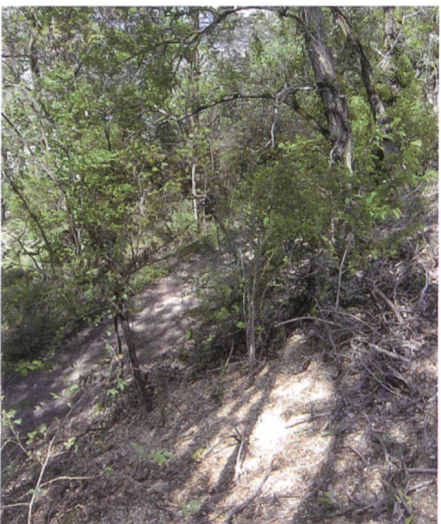
Figure 9. Sentier pédestre au pied de la digue.
