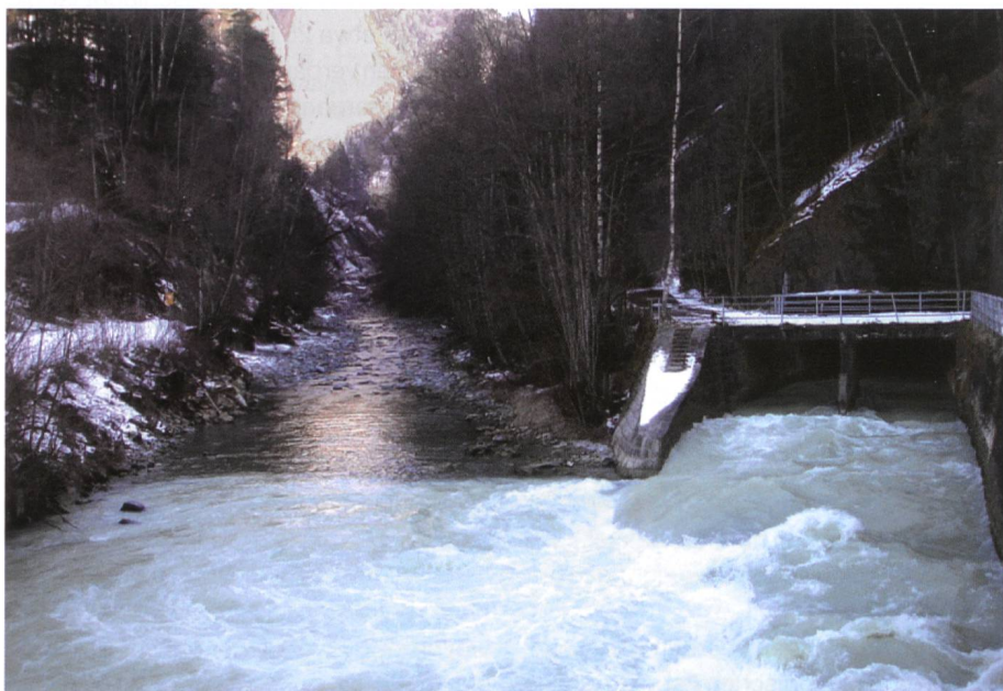
Bild 1a. Rückgabe des aus dem Grimselgebiet stammenden Wassers (rechts) in das Gadmerwasser (links) unmittelbar vor der Mündung in die Aare.
