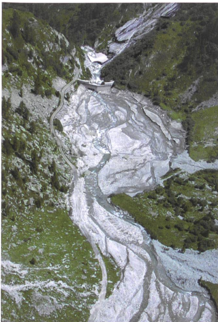
Bild 6. Massive Geschiebeablagerungen beim Rückhaltebecken des Stauwehres Föh am Grossen Wasser (Zwischbergen-tal, Kt. Wallis) als Folge des Hochwassers vom 15. Oktober 2000 (Foto aus Dussex, 2002).
