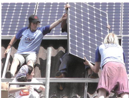
Bild 1. Montage von Solaranlagen in Ruswil.
