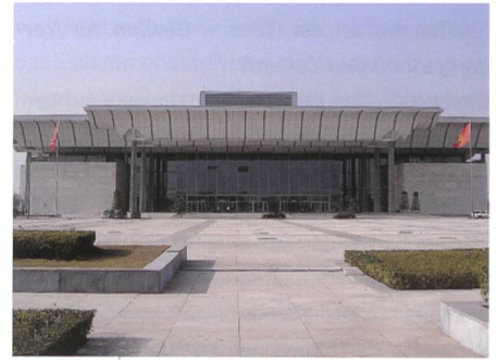
Bild 1. Das neue «National Convention Centre» in Hanoi.
