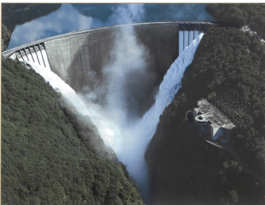
Bild 2. Staumauer Contra der Kraftwerke Verzasca SA.
