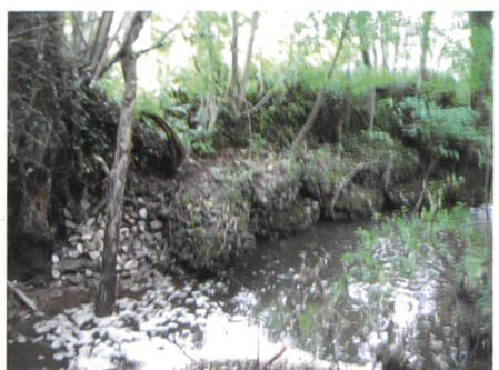
Bild 9. Beispiele für typische Mängel bei kleineren Stauanlagen: a) oben links, verstopfungsanfälliger Weiherauslauf mit Feinrechen und Ableitung in einem Rohr, b) oben rechts, beschädigte Ufersicherung eines Hochwasserableitungsgerinnen, c) unten links, lokal stark durchsickerter Damm und Wasseraustritt auf der luftseitigen Dammböschung, d) unten rechts, erodierter Damm entlang eines Bachs mit beschädigten Drahtschotterkörben am Dammfuss.
