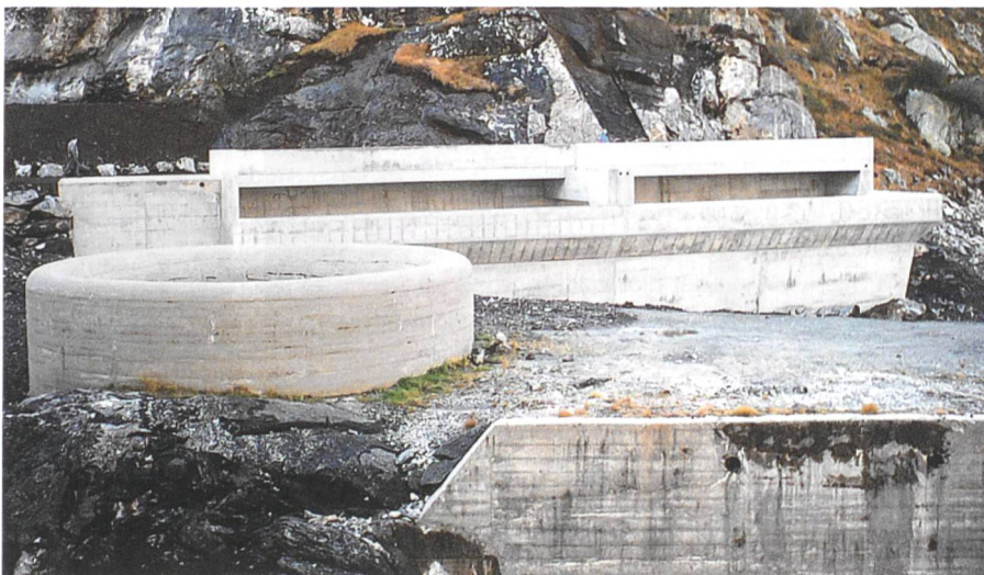
Bild 12. Zusätzliche Hochwasserentlastung, Stauanlage Zött.
