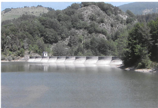
Bild 3. Gewölbesperre Pian Sapeio.
