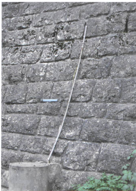
Bild 2. Auftriebsmessung Gübsenseemauer.
