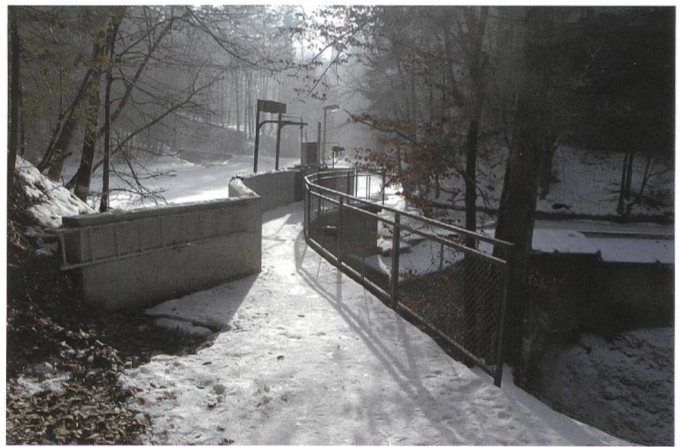
Bild 5. Staumauer, Zugang zum Feinrechen und Steuerung mit dem Stausee im Hintergrund.
