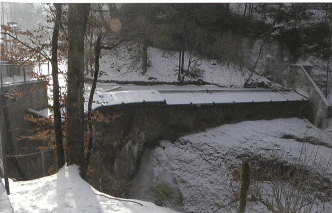
Bild 6. Staumauer im Winter.
