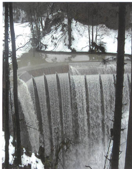
Bild 3. Überfall-Staumauer bei Hochwasser.
