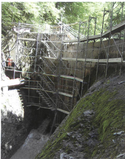
Bild 1. Sanierung Staumauer mit Druckleitung und Grundablass.
