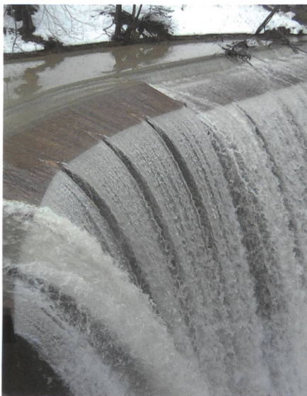
Bild 2. Überfall-Staumauer bei Hochwasser (Detail).
