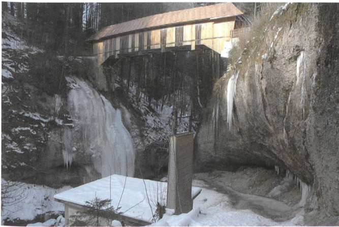
Bild 4. Altes Zentralengebäude mit Verbindungsbrücke über Schlucht.
