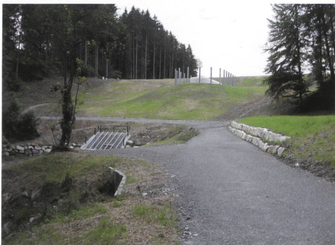
Bild 9. Wasserseitige Böschung mit Einlaufpartie und Hochwasserentlastung.
