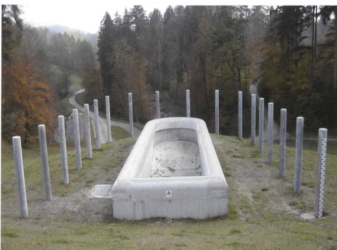
Bild 8. Hochwasserentlastung mit vorgelagertem Schwemmholzrechen.
