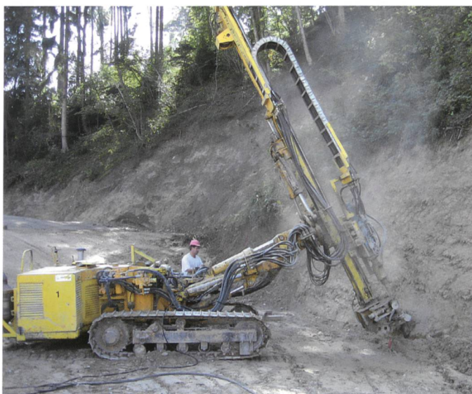
Bild 15. Bohrarbeiten für Injektionen im linken Widerlager.
