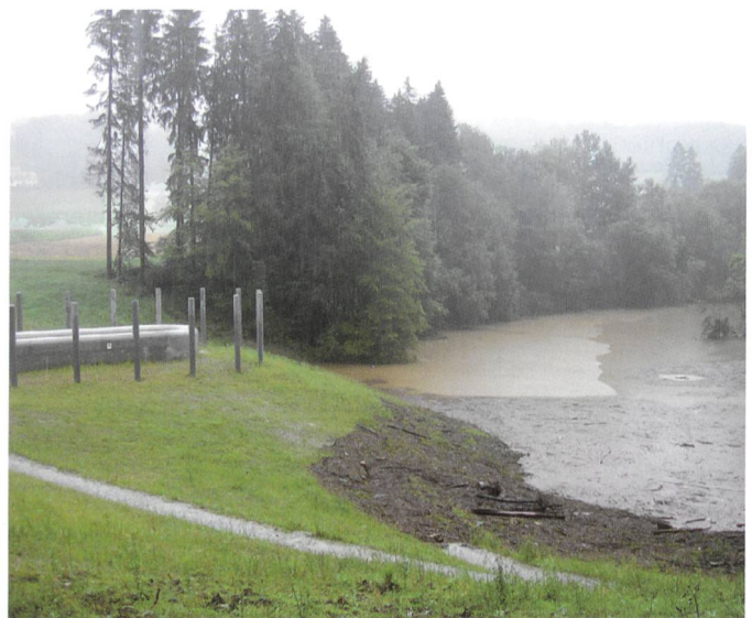
Bild 16. Ersteinstau des Hochwasserrückhaltebeckens am 9. August 2007.
