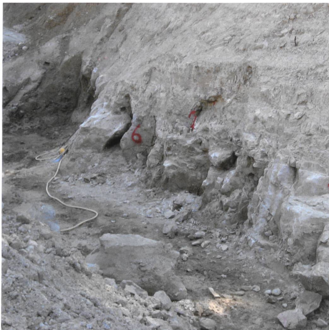
Bild 13. Offene Klüfte/Hohlräume im Bereich der linken Kernaufstandsfläche.
