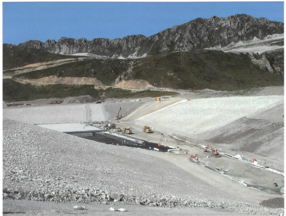
Figure 7. Chantier du barrage d'altitude des Arcs (17 m, 4000000 m 3 ). Ici, la complexité de la géologie et le risque de développement d'une érosion interne dans des cargneules a justifié la pose d'une double géomembrane pour une grande partie de la retenue (diverses couches de cette étanchéité et de sa couverture de protection sont en cours de pose).
