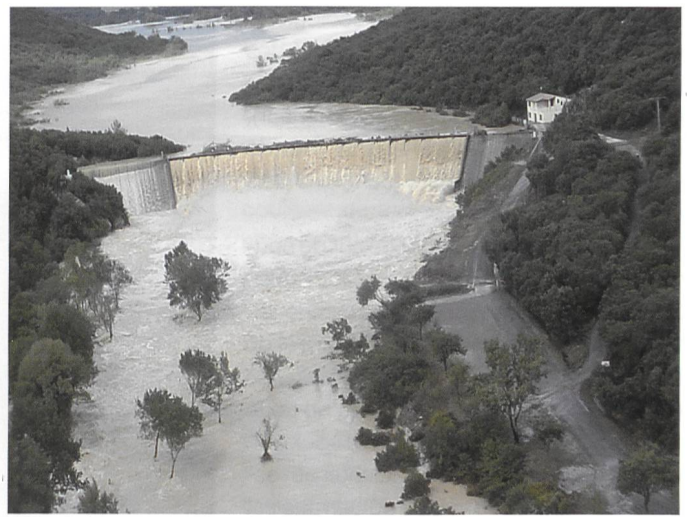
Figure 4. Barrage écrêteur de crue de la Rouvière ( H = 18\text{ m} , 8,3\text{ hm}^3 ) lors de la crue du 9 septembre 2002. Ce barrage, construit en 1970, a connu ce jour là une crue supérieure à sa crue de sûreté et s'est malgré cela bien comporté.
