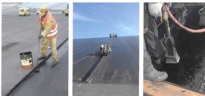
Bild 7. Voranstrich, Aufheizen der Fugen, Nacharbeit mit dem Boschhammer.
