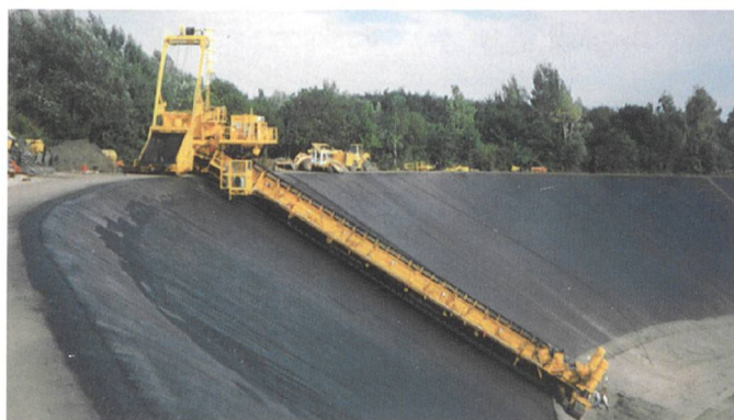
Bild 9. Brückenfertiger im Einsatz beim Pumpspeicherbecken Glems, 1996.
