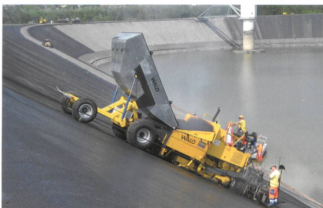
Bild 10. Asphaltarbeiten über Wasser.
