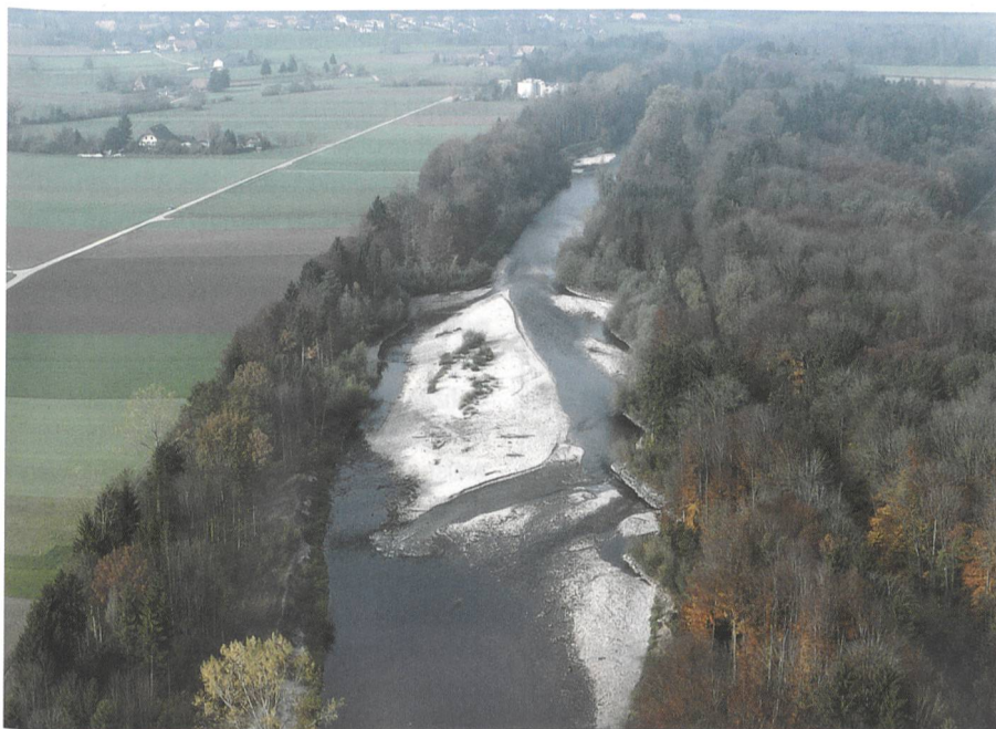
Bild 1. Aufweitung an der Emme bei Utzenstorf (Dokumenta Natura, Bern Oktober 2004).
