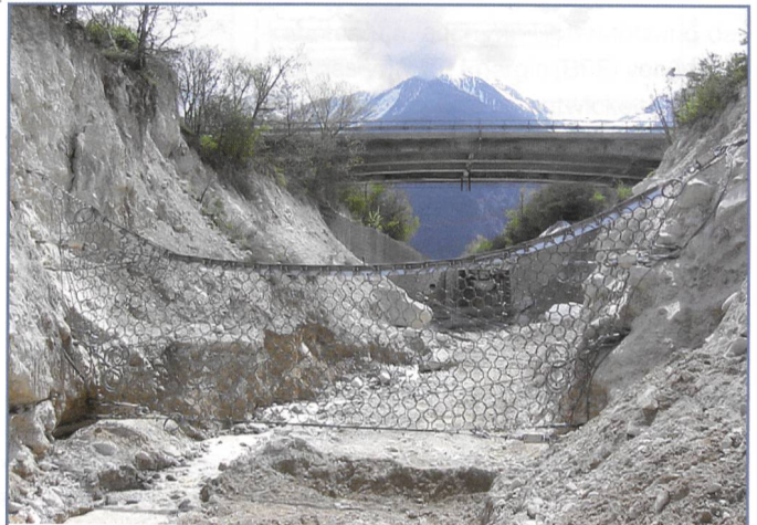
Bild 7. Beispiel von installierter Ringnetzsperrung zum Schwemmholzurückhalt in Österreich.
