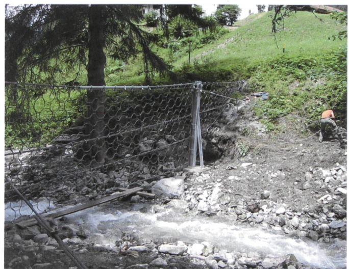
Bild 1. Ereignistypen und ihre Einwirkung auf eine flexible Ringnetzbarriere.
