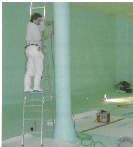
Bild 1. Ein Mitarbeiter von NeoVac prüft vor der Reinigung und Erstfüllung mit grosser Sorgfalt die Dichtheit sämtlicher Schweissnähte.
