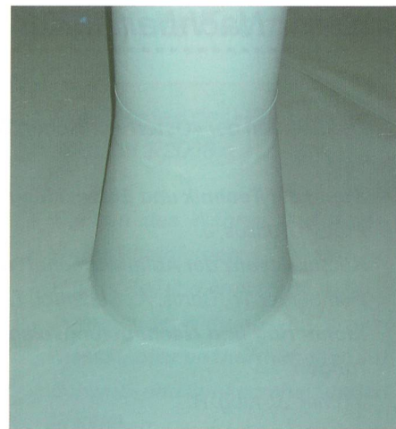
Bild 2. Aufgrund geringem Materialgewicht und bewährter Schweissttechnik stellt das Auskleiden von Säulen kein Problem dar.
