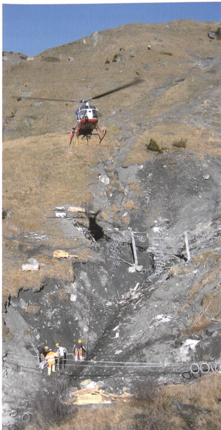
Bild 2. Installation der Barrieren.
