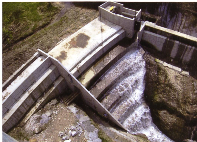
Bild 6. Kaskadenschussrinne über die nach vorn abgestützte Pfeilermauer.
