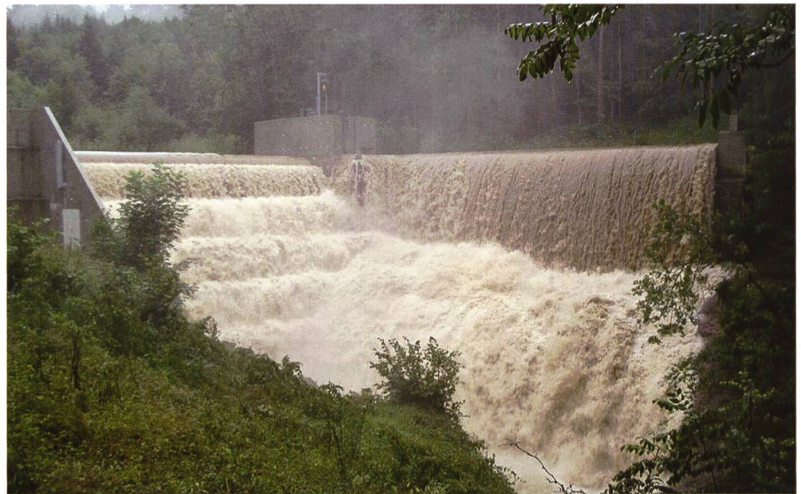
Bild 9. Kaskadenabfluss beim Hochwasserereignis vom 17. September 2006.
