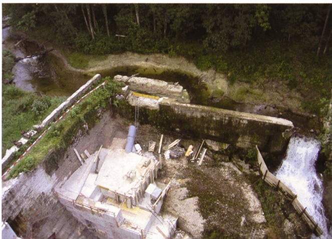
Bild 5. Bestehende Hochwasserentlastung (Streichwehr) während der Bauausführung. Man beachte die erodierte Zone an der Engstelle am linken Widerlager.
