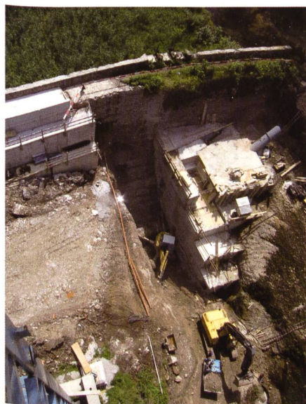
Bild 7. Etappenweises Vorgehen beim Bau zum Erhalt der Standsicherheit im Bauzustand.
