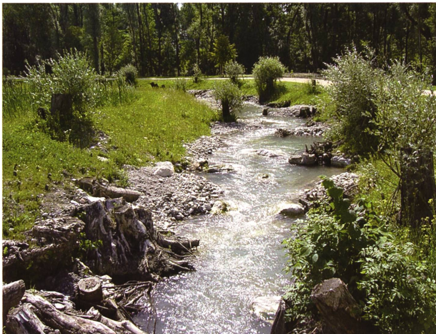
Bild 8. Fischaufstiegsgerinne, Quelle: Salzburg AG.
