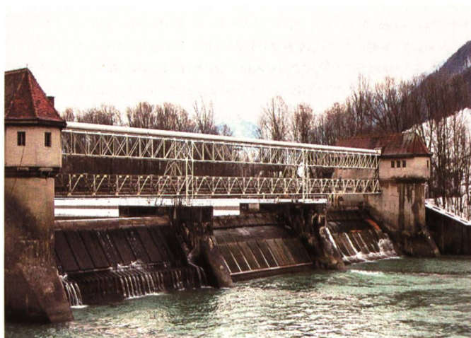
Bild 2. Ursprüngliche Wehranlage – in Betrieb seit 1928 (Ansicht UW-seitig), Quelle: Flögl-BHM.
