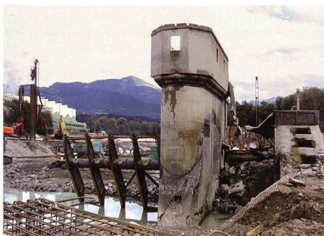
Bild 6. Blick auf «Reste» von Dachwehr und altem Wehrpfeiler, Quelle: C. Peterstorfer.
