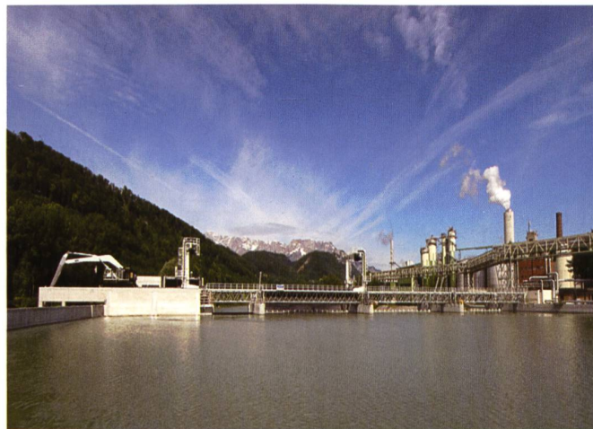
Bild 3. Revitalisierte Wehranlage – in Betrieb seit 2007 (Ansicht OW-seitig), Quelle: Salzburg AG.
