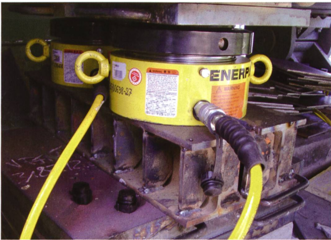
Bild 10. Heben der Kranbahnträger.
