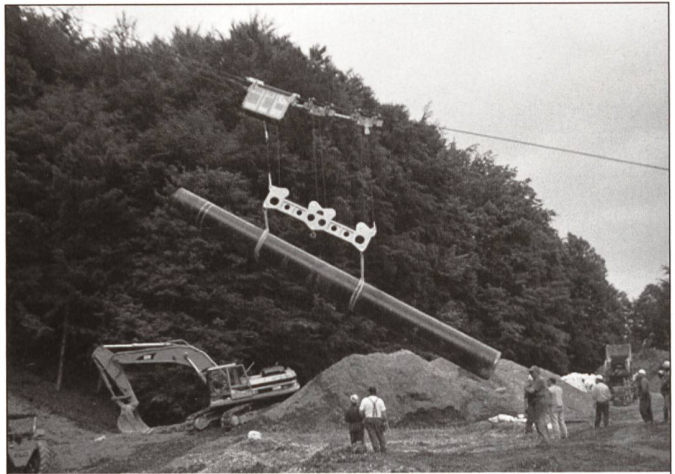
Transport und Versetzen Erdgasleitung, Rohrgewicht 12 Tonnen
