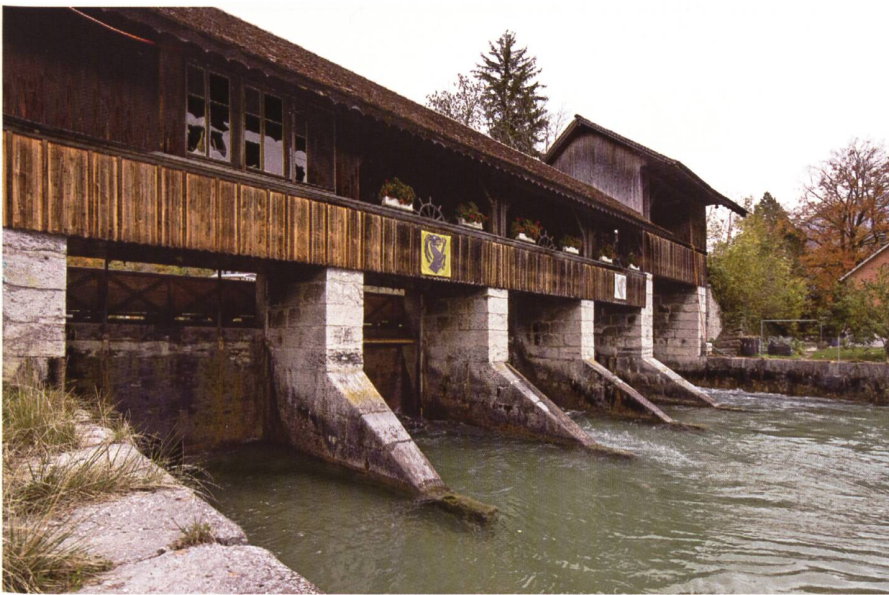
Bild 4. Grosse Staatsschleuse (Quelle [1]).
