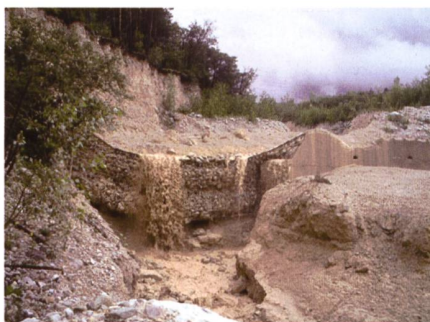
Bild 3. Natürliches Murgangereignis verfüllt die Ringnetzbarriere des ersten Bauabschnittes.
