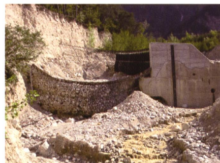
Bild 4. Installation der zweiten Ringnetzbarriere zur Vervollständigung des Umleitbauwerkes.
