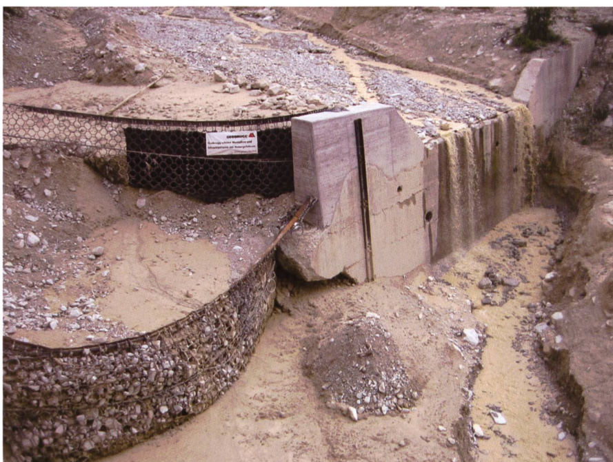
Bild 5. Das Wasser fliesst wieder über die Betonsperre, und die rechte Uferböschung ist vor Erosion geschützt.
