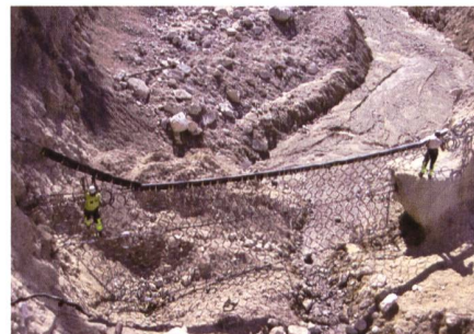
Bild 2. Installation der ersten Ringnetzbarriere.
