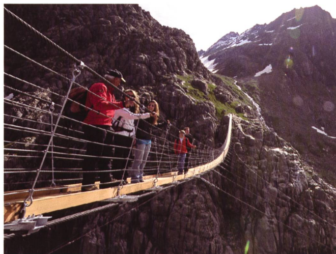
Bild 1. Die «neue» Trift-Hängeseilbrücke. Bild KWO, Foto Robert Bösch.
