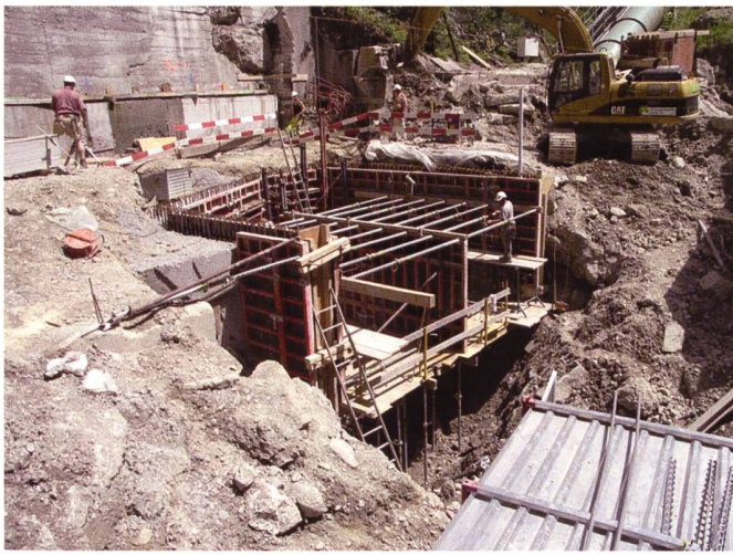
Bild 6. Bau der Zentrale am Fuss der natürlichen Gefällsstufe. Die geologischen Bedingungen mussten gebührend berücksichtigt werden.
