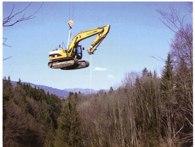
Bild 9. Luftige Bedingungen bei den Erneuerungsarbeiten am Kleinwasserkraftwerk Toppel im Toggenburg. (Bilder: Kraftwerk Toppel AG / HYDRO-SOLAR Engineering AG)
