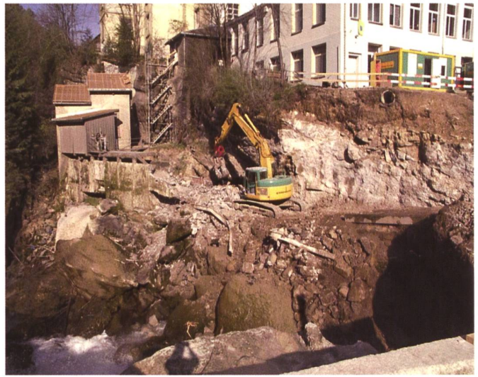
Bild 4. Bauarbeiten für den geplanten Entsander-Teil im Einlaufbereich.
