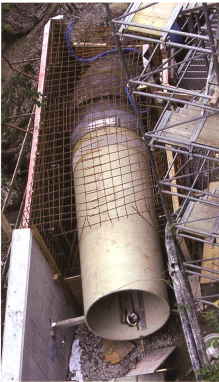
Bild 5. Verlegen der glasfaserverstärkten Druckleitung.
