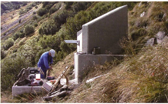
Bild 2. Bau einer Konsole an einem Lawinenschutzkeil.
