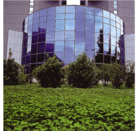
Bild 1. Das TIS-convention-center in Bozen, Italien.
