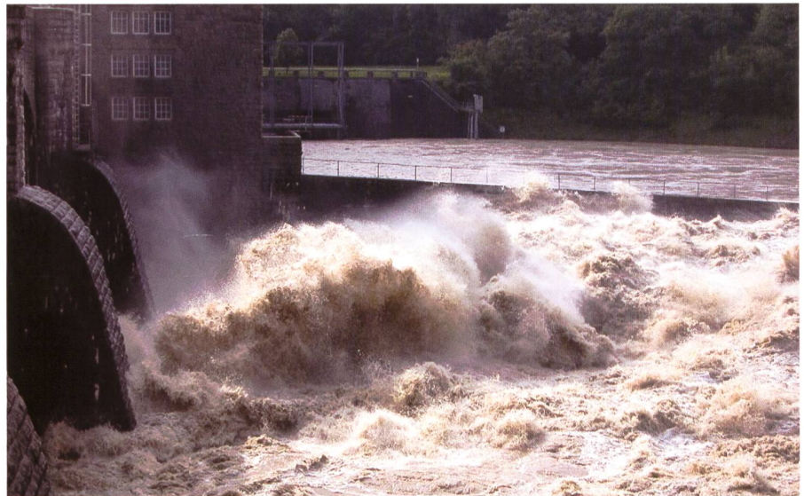
Bild 10. Die Wehranlage mit rund 2200 m 3 /s durch zwei Wehrfelder. Im Vordergrund Wehrfeld 3 ohne Abfluss, aufbäumende Wassermassen beim alten Wehrfeld 2 und die lange Dissipationszone nach dem umgebauten Wehrfeld 1 (vor der Betonleitwand zum Kraftwerksauslauf).
