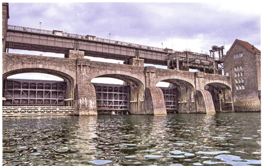
Bild 11. Die obere Hälfte der Wehranlage, die aus dem Unterwasser ragt, wurde durch den Umbau nicht verändert.
