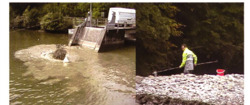
Bild 6. Das vor den Einlauf gepumpte Wasser-Sediment-Gemisch anlässlich der Testbaggerung (links) und Personal der SAK bei der Entnahme einer Wasserprobe in der Sitter, rund 300 m unterhalb des Eintritts des Unterwassers in den Fluss (rechts).
