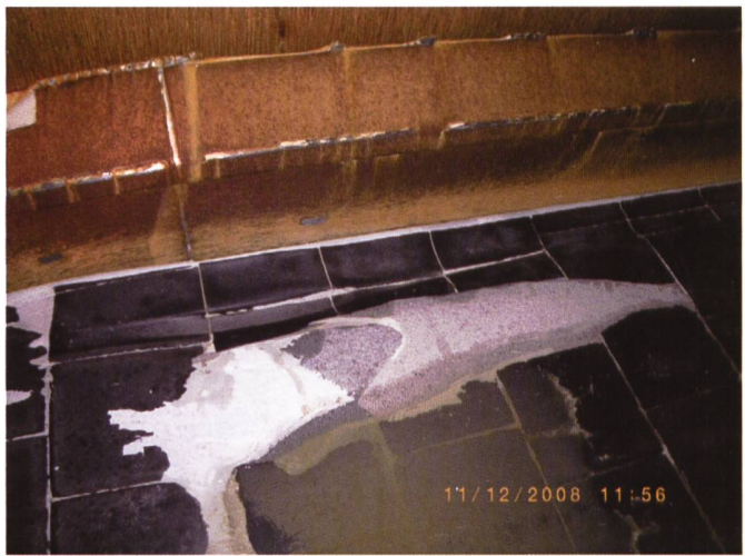
Bild 4. massiver Verschleiss an aufwändiger Basaltpanzerung.
