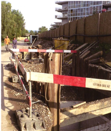
Bild 2. Abwasserwärmanlage Wässerwiesen Winterthur, Bauarbeiten Abwasserkanal, September 2009.
