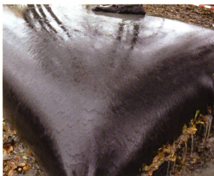
Bild 2. Während der Schlamm im Geotube® festgehalten wird, kann das Wasser ausfliessen. (Bild: mmi)
