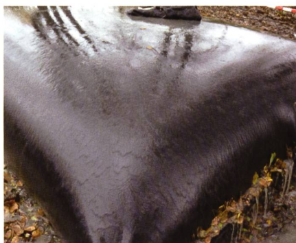
Bild 2. Während der Schlamm im Geotube® festgehalten wird, kann das Wasser ausfliessen. (Bild: mmi)
