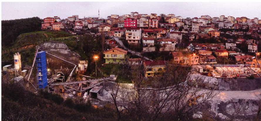
Bild 3. Startschacht (links) und Tübbingfertigung (rechts) im Stadtteil Sariyer im europäischen Teil Istanbul.
