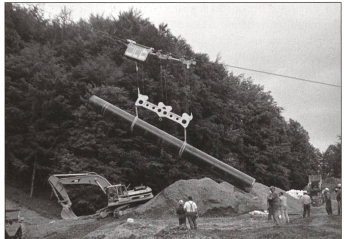
Transport und Versetzen Erdgasleitung, Rohrgewicht 12 Tonnen
