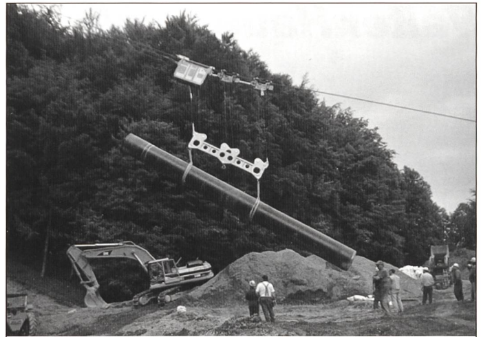
Transport und Versetzen Erdgasleitung, Rohrgewicht 12 Tonnen
