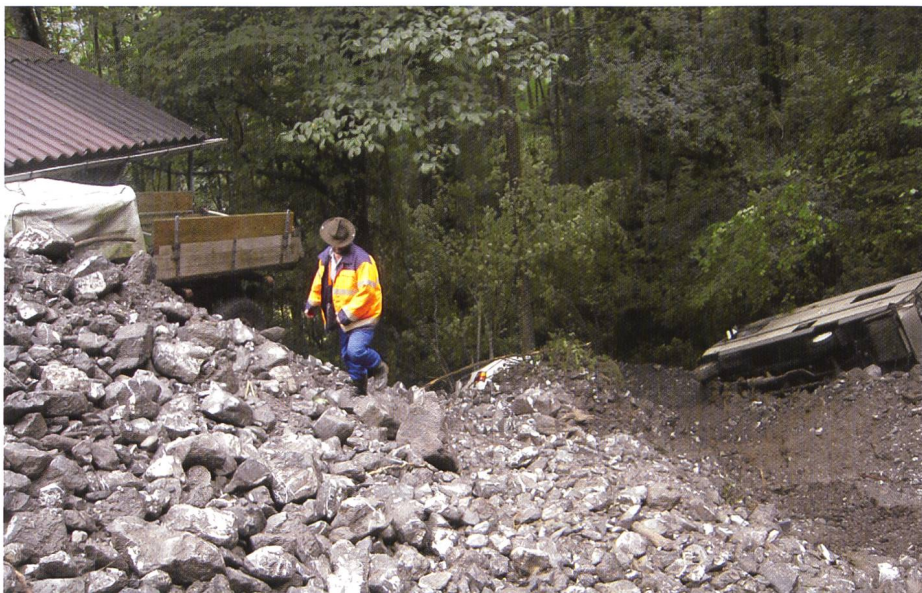
Bild 5. Murgänge in der Dornirunse zerstörten am 3. August eine Garage und Fahrzeuge (Amt für Wald und Naturfahren, Kanton Schwyz).
