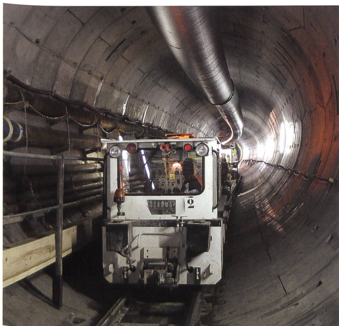
Bild 5. Innenansicht des Stollens während der Bauarbeiten (Quelle: ARGE AHT).
