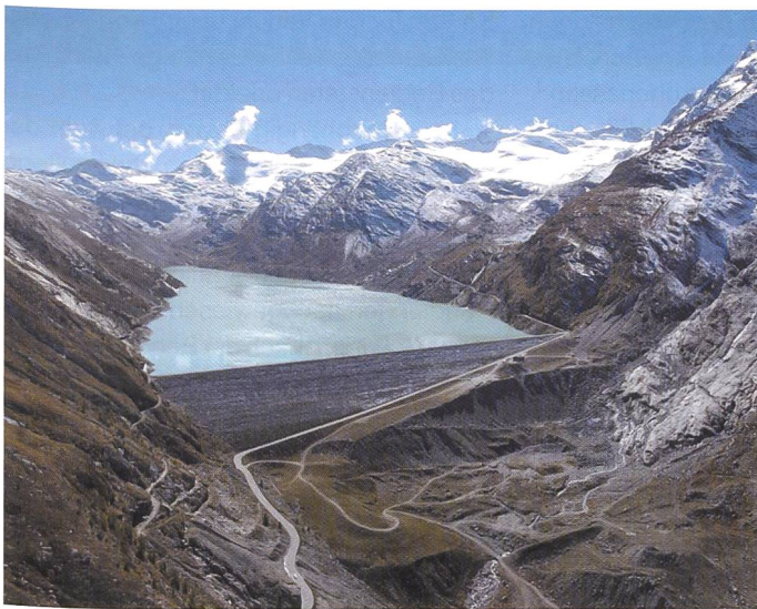
Bild 2. Talsperre Mattmark bei Saas Almagell im Wallis, (Foto: Mattmark AG).
