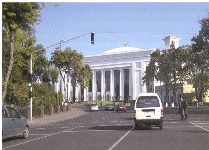
Bild 31. Neues Kongresszentrum Taschkent, 2009.
