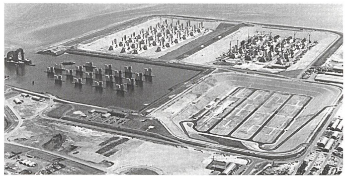
Bild 16. Die Baugrube Schaar mit den vier Docks.
