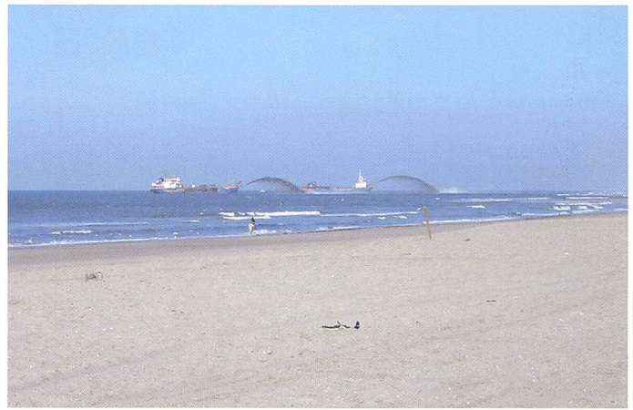
Bild 26. Aufspritzen von Sand an der Küste.
