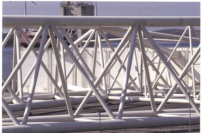
Bild 22. Ausschnitt aus einem der beiden Fachwerkarme.
