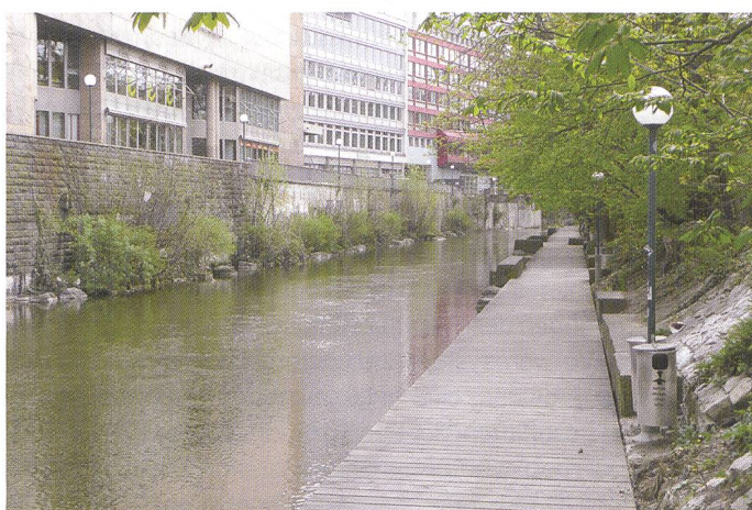
Bild 6. Fussweg entlang des Schanzengrabens.
