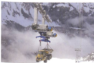
Bauseilbahn 1 nimmt den Betrieb auf.
