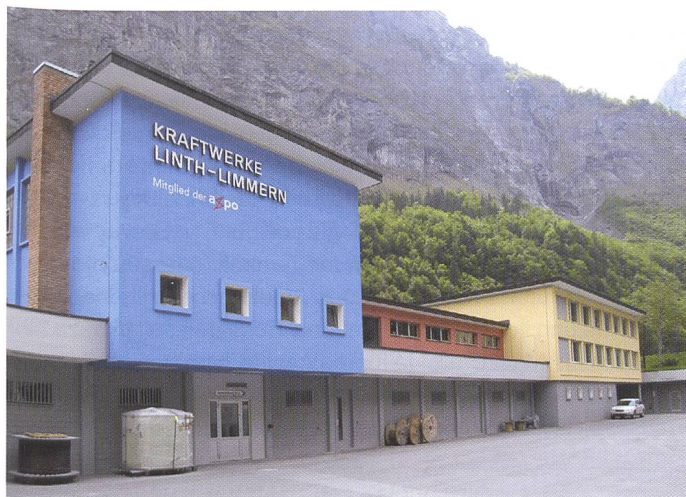
Kraftwerkszentrale Linth-Limmern in Linthal.
