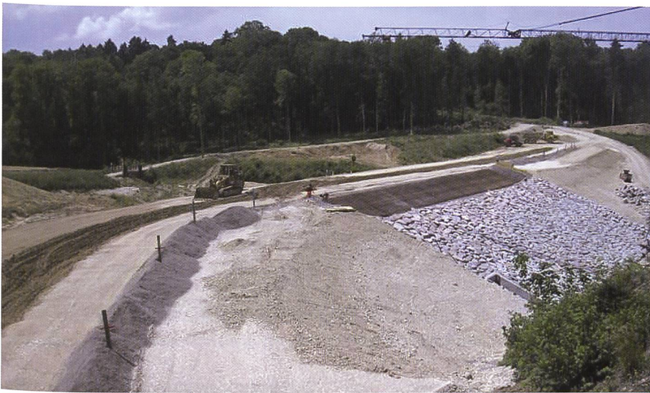
Bild 5. Draufsicht auf Damm mit erkennbaren Dammmzonen.
