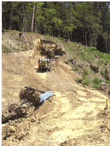
Bild 12. Injektionsbohrungen für Untergrundabdichtung.
