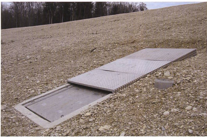
Bild 8. Notentlastung mit Tafelschieber.
