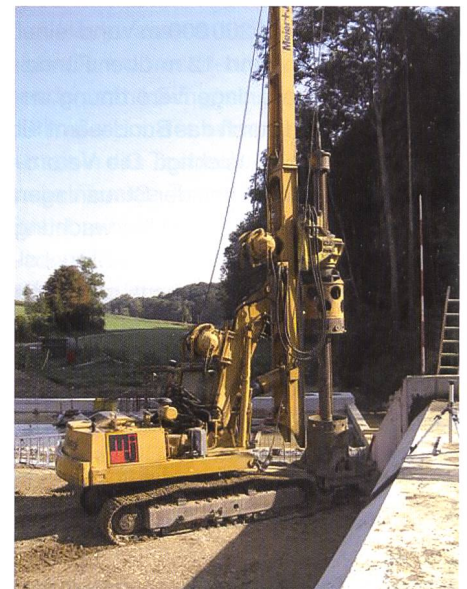
Bild 13. Filterbohrungen (d=80 cm) als Entlastungsfilter gegen Auftriebssicherheit.
