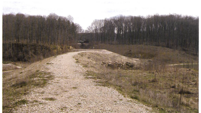
Bild 19. Sicht auf den Damm in östlicher Richtung Ende März 2010.
