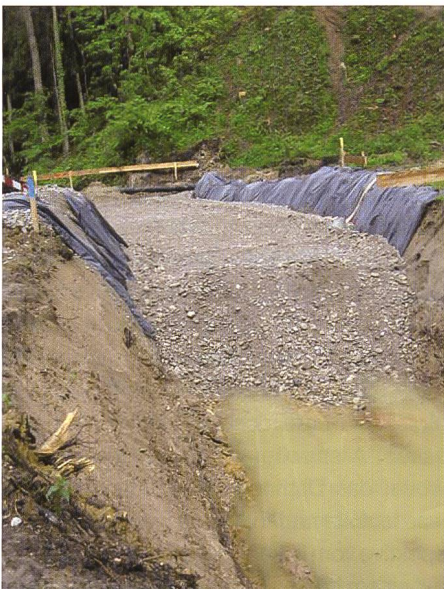
Bild 11. Materialersatz unter dem Durchlassbauwerk.
