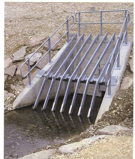
Bild 7. Einlaufbauwerk mit Drosselöffnung und Grobrechen.
