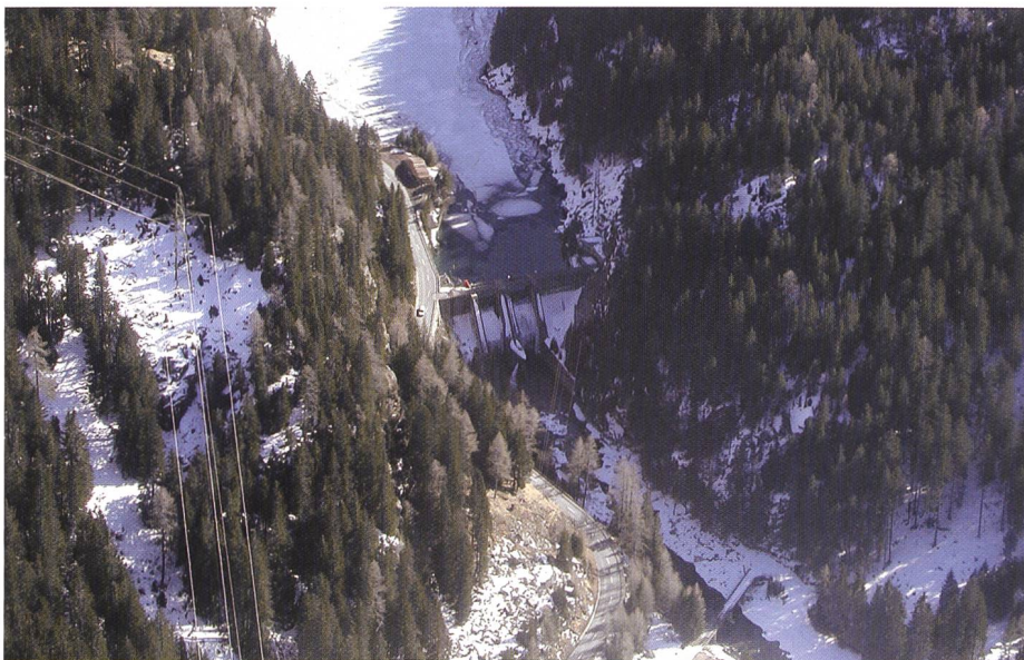
Bild 9. Ausgleichsbecken Ferrera, Schwergewichtsmauer: Höhe 28.00 m, Kronenlänge 61.00 m, Nutzvolumen 230000 m 3 .
