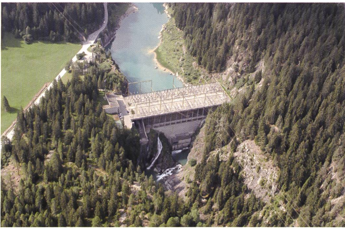
Bild 10. Ausgleichsbecken Bärenburg, Schwergewichtsmauer: Höhe 64.00 m, Kronenlänge 110.00 m, Nutzvolumen 1 000 000 m 3 .
