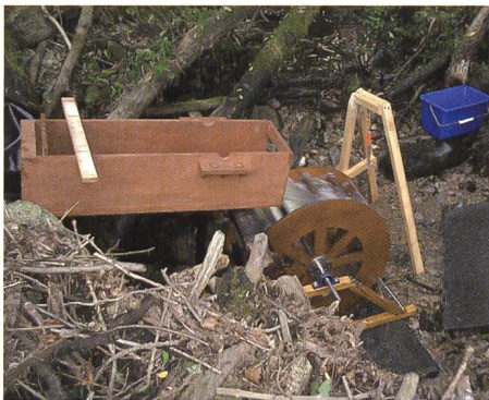
Bild 8.8. Das Rad wird installiert.
