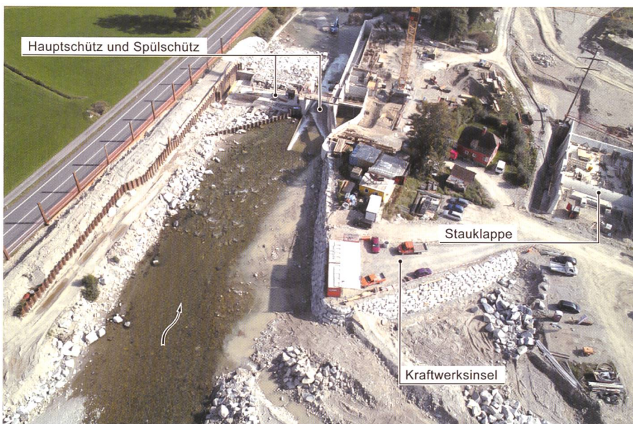
Bild 11. Baustelle der Holzrückhalteanlage im September 2010. Quelle: vif, Kanton Luzern.
