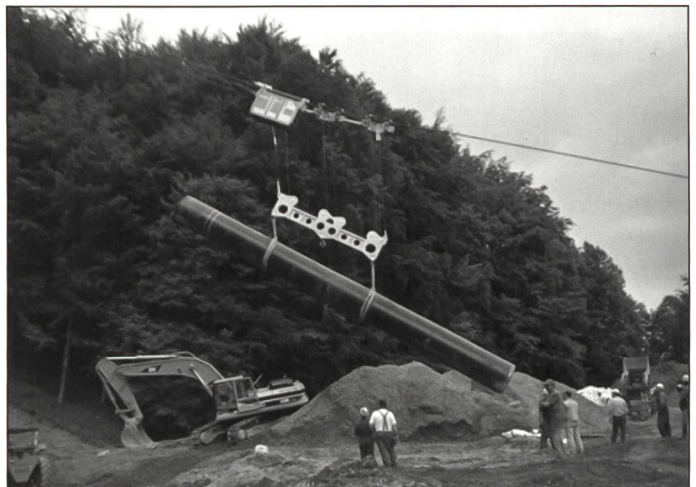
Transport und Versetzen Erdgasleitung, Rohrgewicht 12 Tonnen
