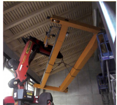
Bild 23. Montage 16-t-Kran.
