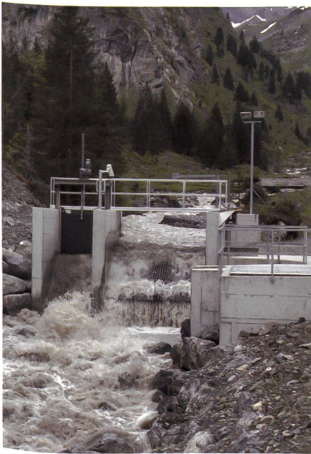
Bild 20. Bereich Fassung im Herbst 2009.
