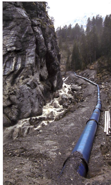
Bild 12. Versetzte Druckleitung in Etappe 4 im Dezember 2008.
