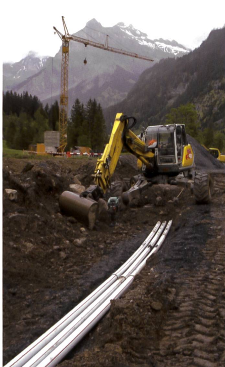
Bild 9. Eindecken der 3 Kabelschutzrohre in Etappe 1 (oberhalb Maschinenhaus).
