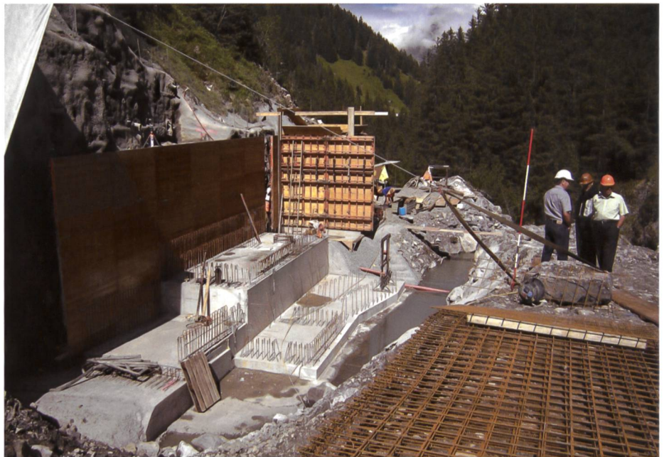
Bild 16. Erstellen des IDM-Schachtes (eingeschalt) mit Sicht auf Absatz des Einlaufbeckens.
