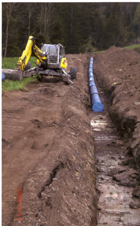
Bild 8. Versetzte Druckleitung in Etappe 1 (oberhalb Maschinenhaus).
